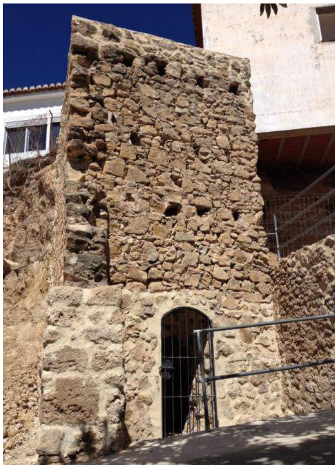
Exterior del cubo de la Rocha Palmera
