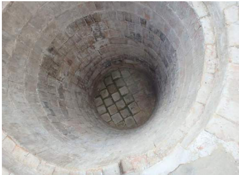
Interior del cubo Alonso recién limpiado en junio de 2016
