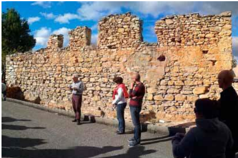
Los mismos cubos colectivos de Herragudo donde ya se pueden observar los caños de salida o bocanas.
