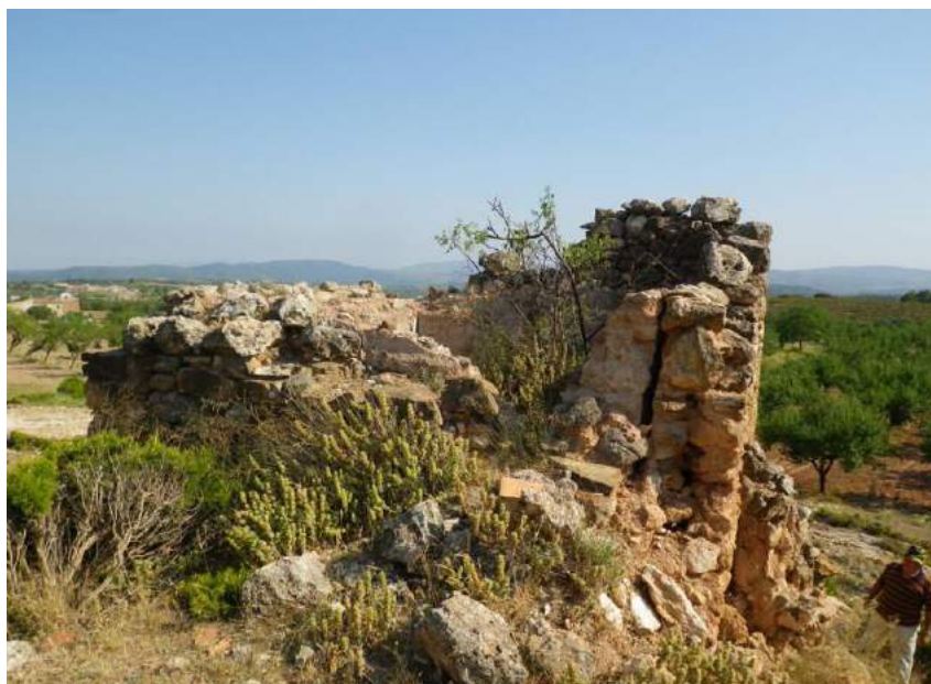
Estado ruinoso del cubo cerca de la Ermita de Ragudo
