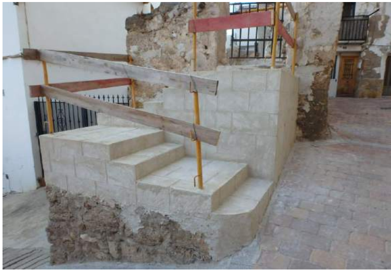
Trabajos de acondicionamiento del acceso al cubo Alonso
