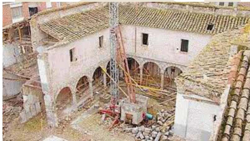
Primera fase del proceso de rehabilitación del convento
