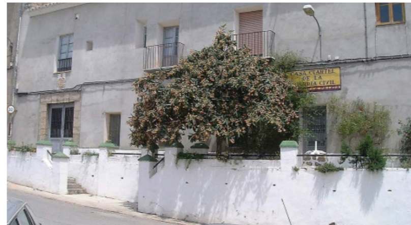
Fachada del convento siendo dependencia del cuartel de la Guardia Civil
