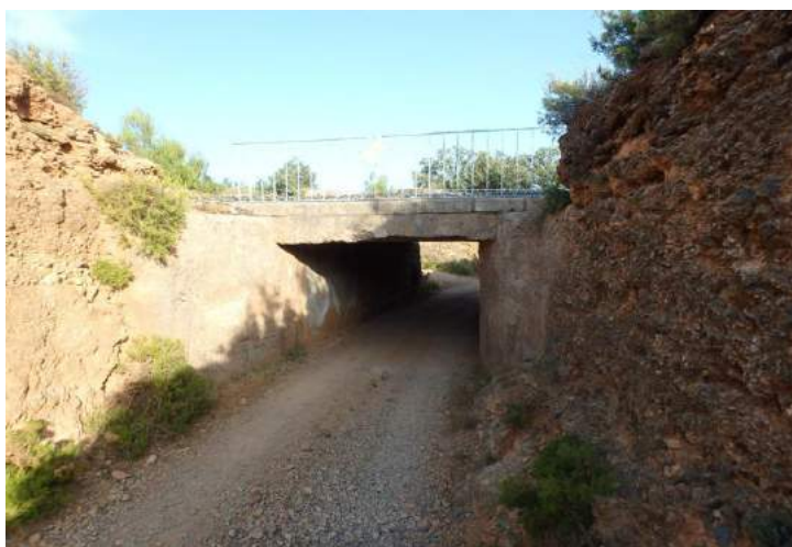
Paso de la Cañada de Benabal cerca de la Estación de los Planos
