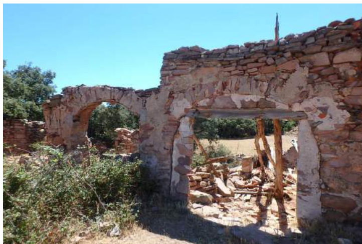
Ejemplo de casa en ruinas en Monleón
