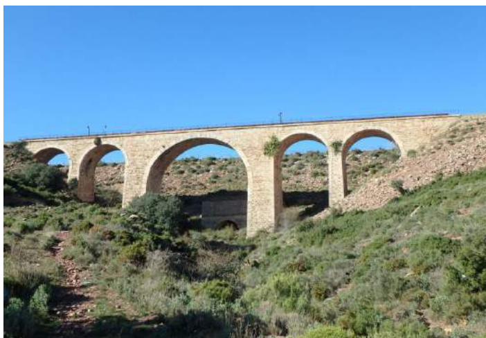
Puente de la Hoya del Agua, utilizado por la vía del tren para cruzar dicho barranco
