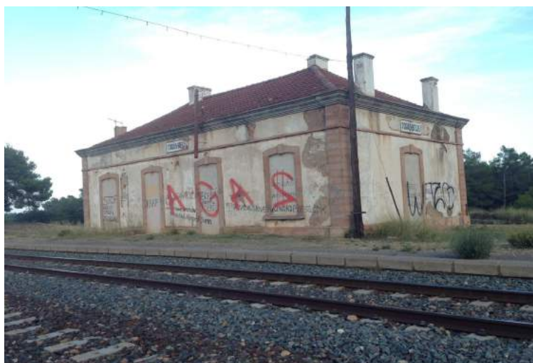
Estación de Torás Bejís (Hoy fuera de servicio).
