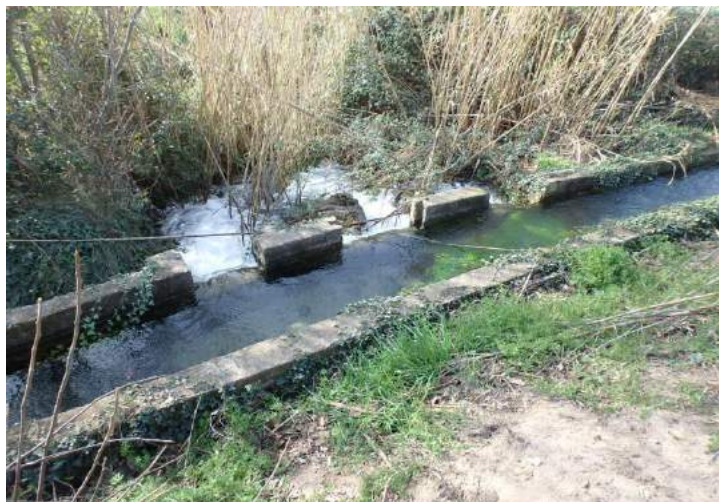
Parada de la Almenara vaciando la acequia para proceder a su limpieza
