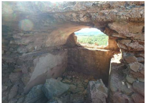
Interior de uno de los búnkeres
