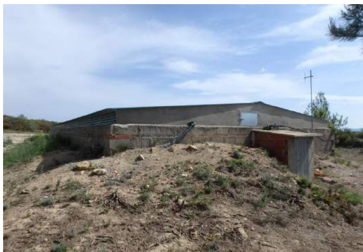
Balsa de riego, toda cubierta, en el Alto Porter/Mazorral
