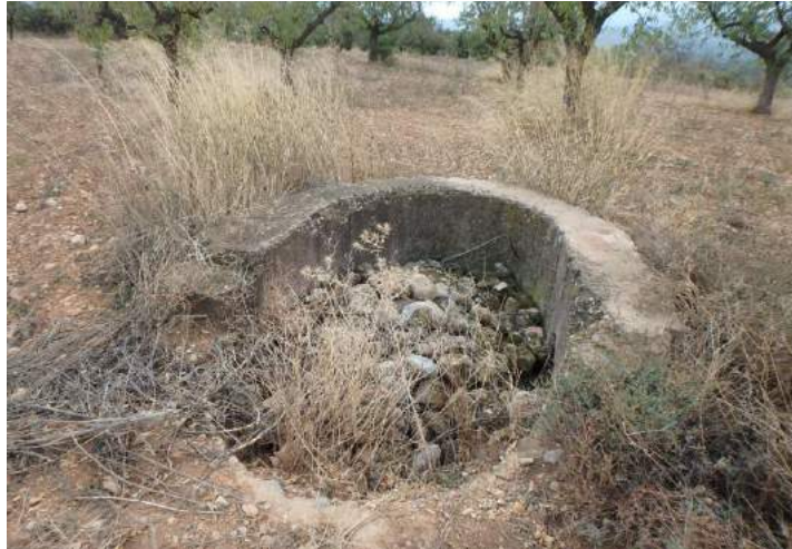
Lo que fue la boca superior de un refugio, hoy colmatada para evitar riesgos
