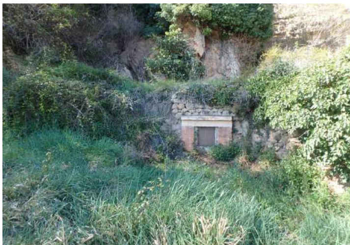
Caseta de captación del Manantial de la Chorrera
