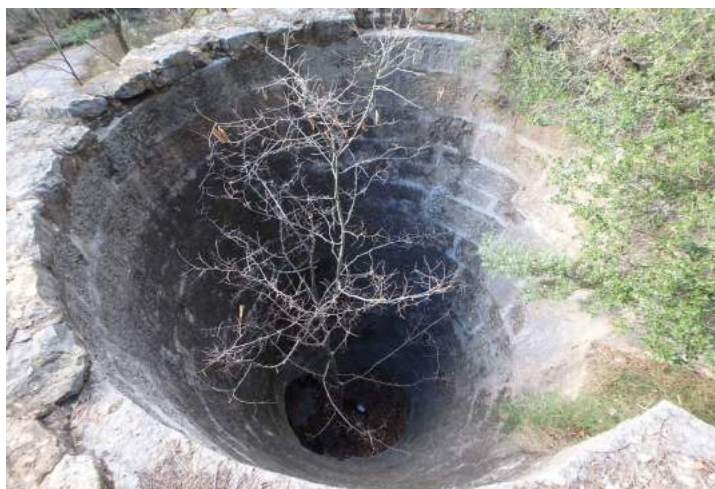
Entrada del agua en la antigua Fábrica Vieja de la Luz
