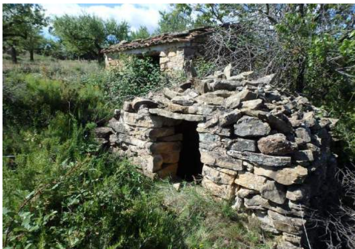
Aljibe de la Mezquetilla, en bastante buen estado de conservación
