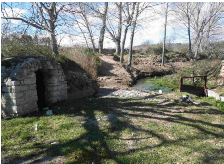
Partidor de Magallán, punto donde se inicia el sistema de acequias
