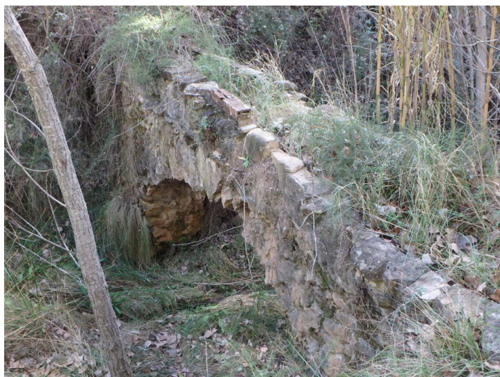
Acueducto de la acequia de Pocopán sobre el barranco de los Vallejos
