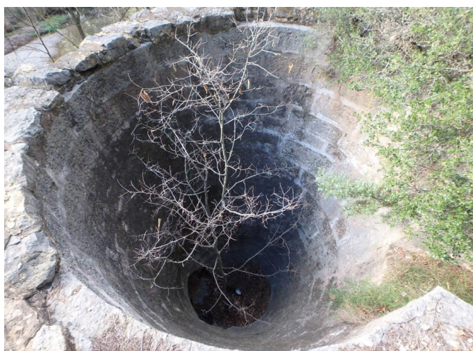
Entrada del salto en curiosa forma cónica en la Fábrica de la Luz Vieja de Pocopán
