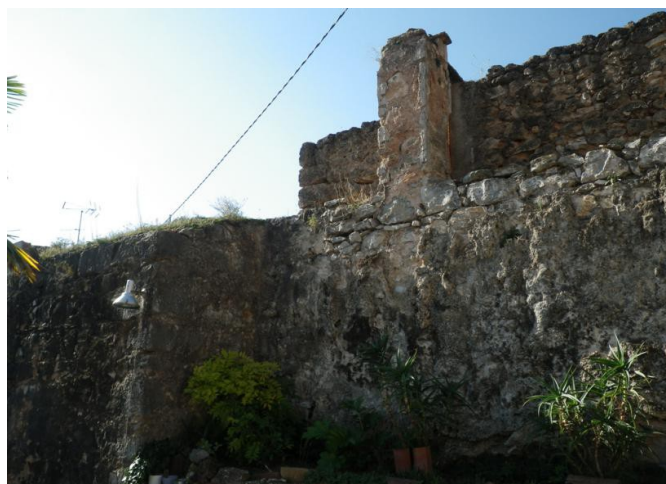
Muro para el caz del Molino de Ribera
