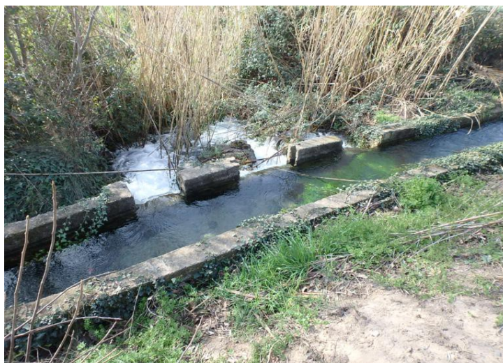
Parada de la Almenara, en funcionamiento para sacar las aguas, por labores de mantenimiento, de la Acequia de Magallán
