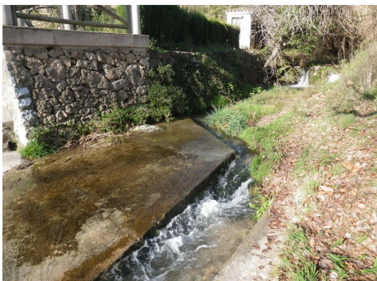
Desagüe del Barranco Hurón e hijuela del Pontón, en el Río Palancia
