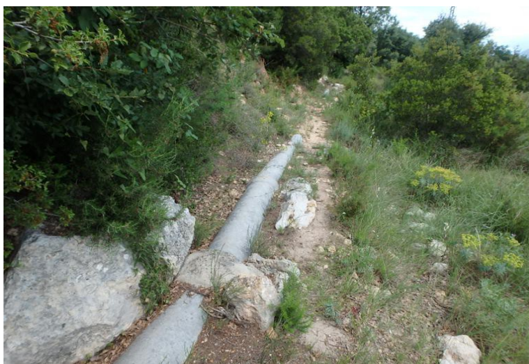
Tramo de acequia entubada del Cárcabo
