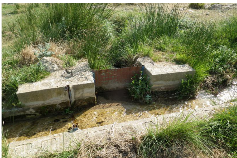
Partidor del Brazal de la Ermita
