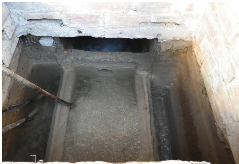
Interior del Partidor de Bajo Molino, de donde parte la acequia de Lunes Noche, y en el que se aprecia el peculiar rollo para Mediavega de Jérica
