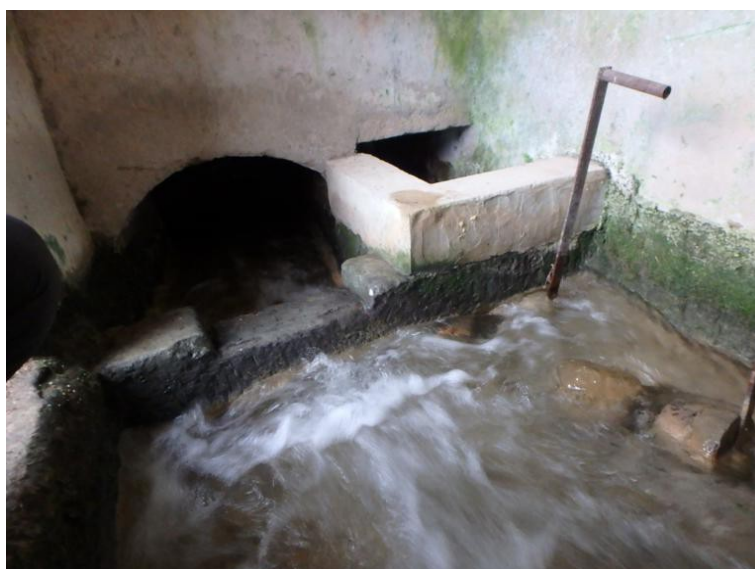
Interior del partidor del Cárcabo, donde se intuyen los 5 rollos
