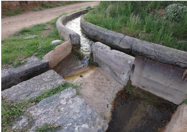
Parada del Banco, aliviando excedentes de agua
